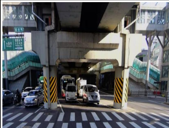
P14 교각 전면 전경
