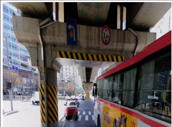
P14 교각 배면 전경
