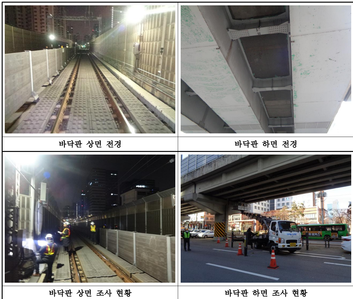
【그림 II-6.3.1】 바닥판 현황 및 조사 전경
