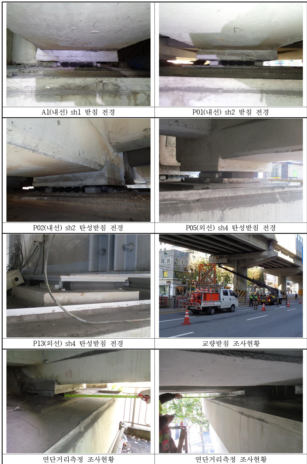
【그림 II-6.3.17】 교량받침 현황 및 조사 전경
