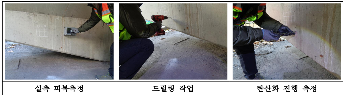
【그림 II-6.3.30】 탄산화 깊이 측정 절차
