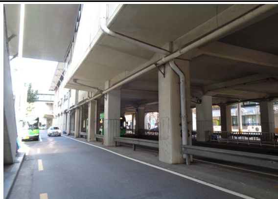
당산역하부 측면 전경
