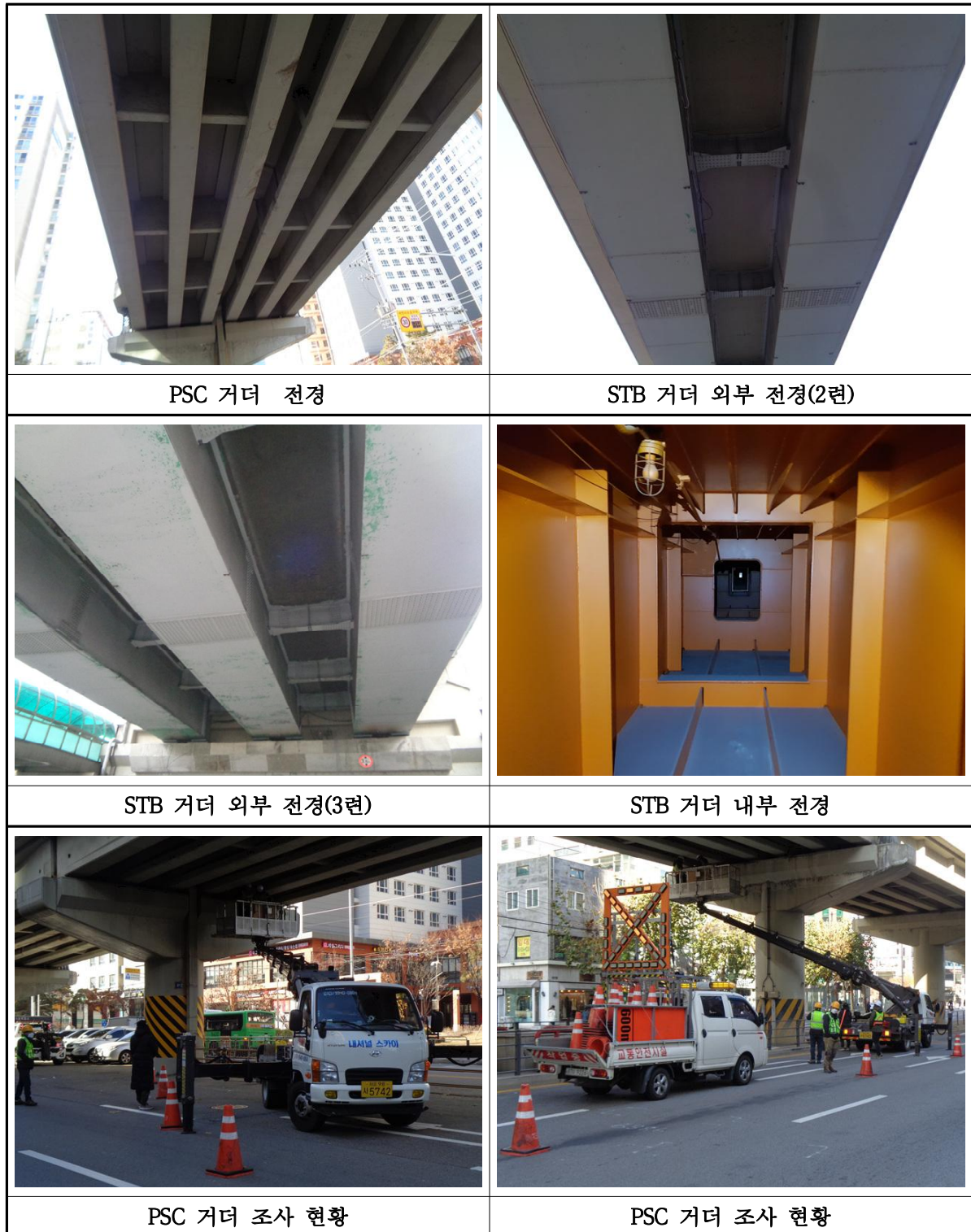
【그림 II -6.3.4】 거더 현황 및 조사 전경
