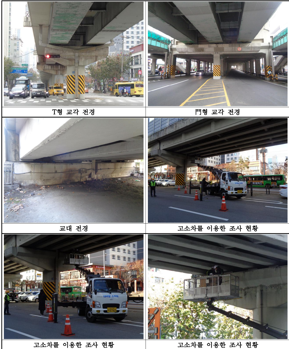
【그림 II-6.3.9】 하부구조 현황 및 조사 전경
